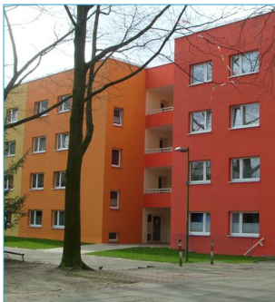
Modernisierung und Rückbau im Quartier
